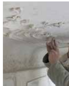
Restauratie stucwerk Hof te Baeyghem
